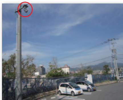
福江港ターミナル設置のITSスポット
